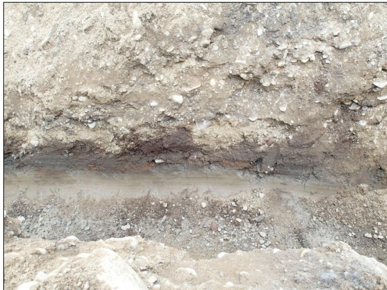
Kaapelikaivannon seinämää ojan länsipuolella pihatien kohdalla
