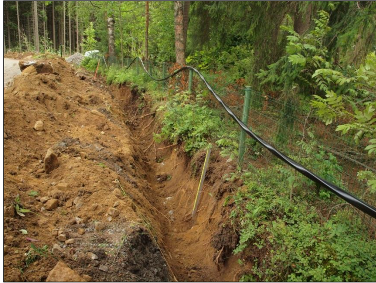
Kaivannon poikkileikkaus muinaisjäännösalueen länsiosassa
