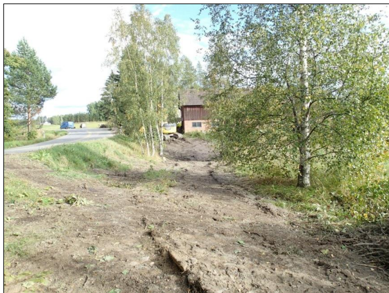
Peitettyä kaivantoa ojan kahden puolen.
