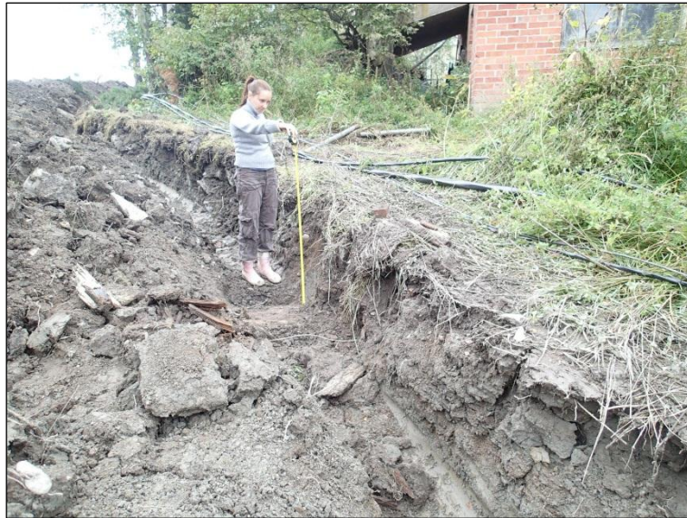
Kaapelikaivantoa ojan itäpuolella navetan nurkalla
