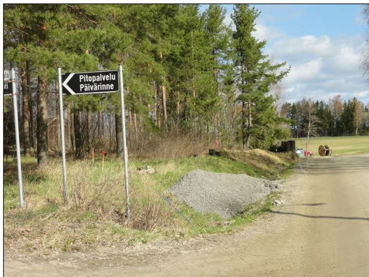
Kaapelilinjaa Rautialantie varrella - tienviitan alla paalut. Pohjoiseen.
