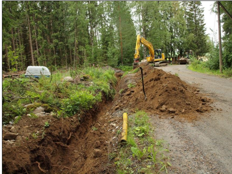
Linja kaivettuna tien alituksesta metsätielle saakka länteen.
